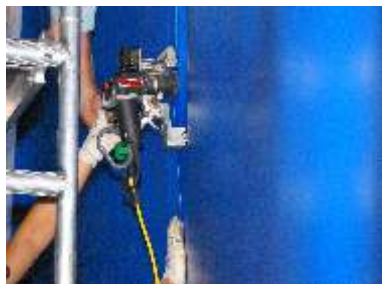
Verschweißung der Bahnenstöße mit Heißluftschweißmaschine
